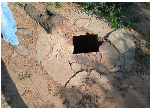
Figura 5. Registro del sistema de alcantarillado sanitario en estado de deterioro y abandono.
